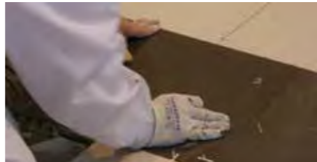
Colocar la pieza de porcelánico Todagres / Lay the Todagres ceramic tile.
