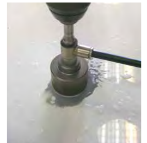
Perforación de gran diámetro / Big diameter drill.
